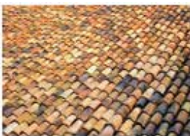
Kiremit ve Tuğla Atıkları
